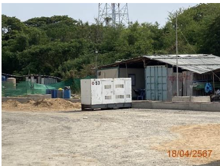
ภาพที่ 2.2-22 การปิดครอบเครื่องจักรจาก แหล่งกำเนิดเสียง
