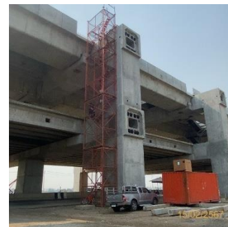
ภาพที่ 2.2-44 บันไดสำหรับใช้ก่อสร้าง
