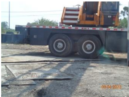
ภาพที่ 2.2-20 การวางแผ่นเหล็ก
